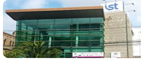
Hospital Clínico IST Viña del Mar
